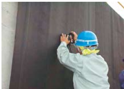
④ 電磁誘導加熱機による溶着
