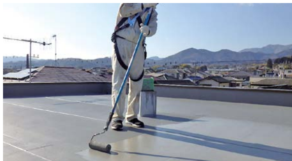
●仕上塗料はむらなく均一に塗布する。
