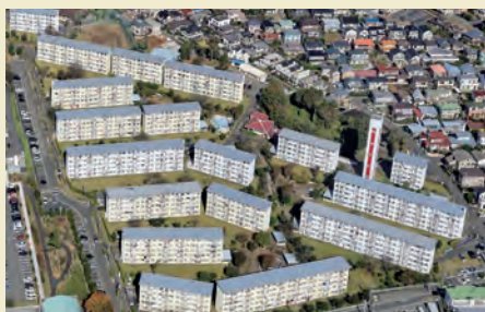
集合住宅の屋上防水に使用されている“ニューブレンド防水工法”
