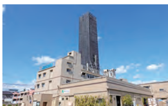
広告塔解体工事中
