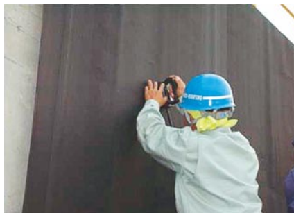
②電磁誘導加熱機による溶着
