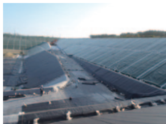
処分場で遮水シートとして使用される「ディスプレイナー・シリーズ」
