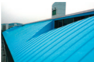
金属屋根をゴム系材料で覆い改修する 「リプルーフ防水工法」
