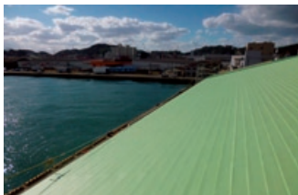
金属屋根を加硫ゴムシートで覆い改修する「ステージーフ防水工法」
